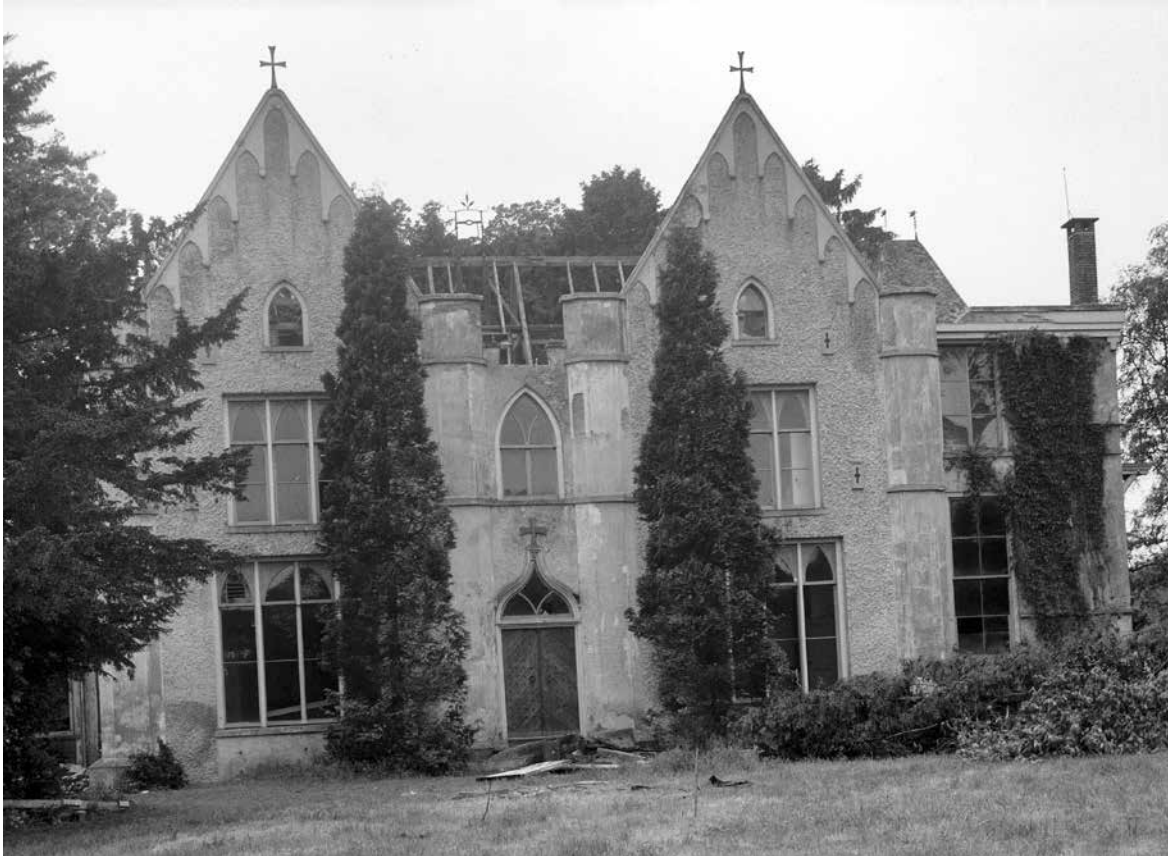
Landhuis Oud Rande waarvan het dak reeds is gesloopt. Afbeelding Rijksdienst voor Erfgoed, nr.087235.
